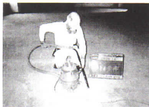
図 3. 115 清掃 高性能真空掃除機使用例
