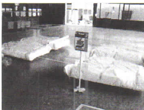
図 3. 116 石綿含有成形板廃棄物の保管例
