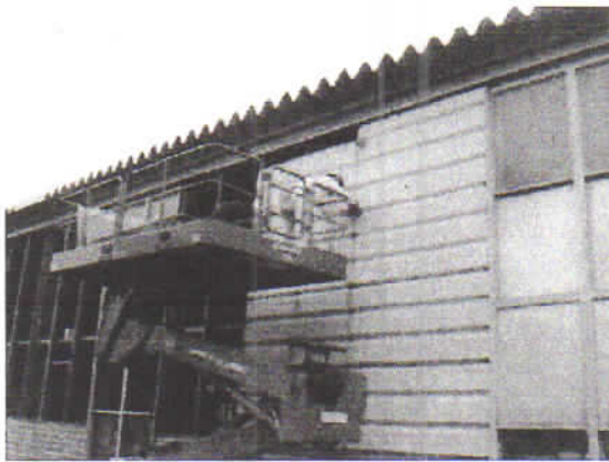
壁金物取外し
