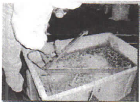
図 3. 118 掻き落とし除去作業の例
