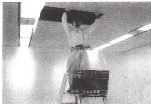
図 3.110 天井石綿含有成形板の除去例
