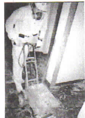
図 3. 114 石綿含有ビニルタイルの除去例
