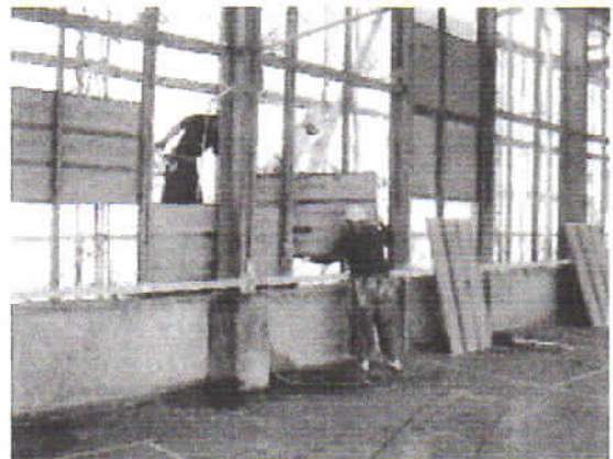
壁石棉含有成形板取外し
