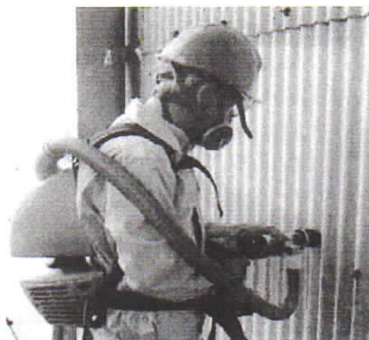
図 3.111 機械工具による切断例
