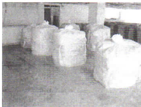
図 3. 116 石綿含有成形板廃棄物の保管例
